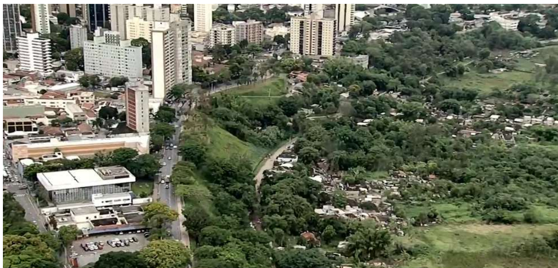
Ocupação irregular da área do banhado em contraste com a área urbanizada: fonte Prefeitura de São Jose dos Campos.
