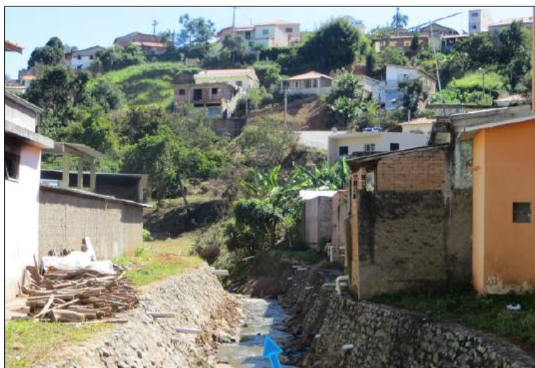
Figura 12: Domicílios do bairro Várzea do Gouvea com presença de esgoto via rio. A seta em azul indica a direção do curso d'água. Fonte: CPRM, 2017.
