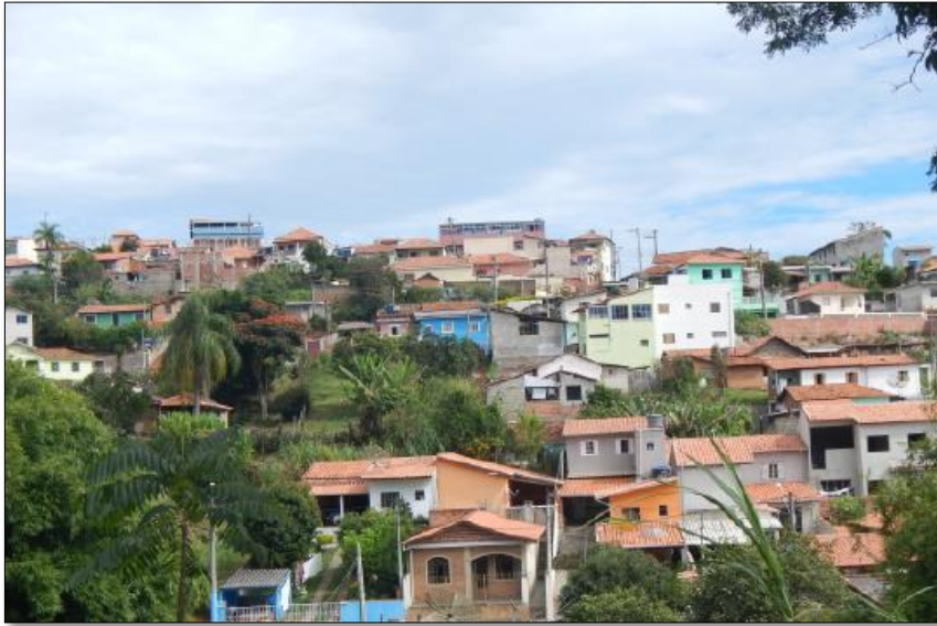
Figura 10: Bairro do Motor com presença de domicílios em locais impróprios, com risco de deslizamento. Fonte: CPRM, 2017.
