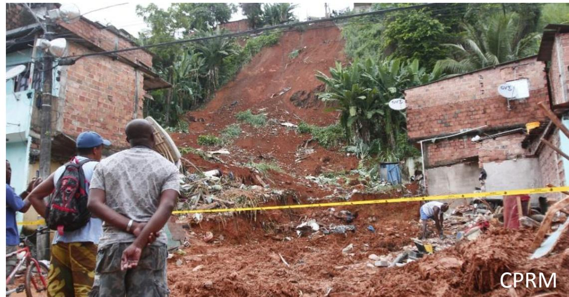
A presença de fossas favorece a ocorrência de deslizamentos, acelera a erosão do talude e pode saturar o solo (Mirandola & Macedo, 2014).
