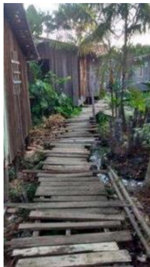
Figura 2.4: Acesso por estivas no assentamento Baixa Verde em Cametá.
