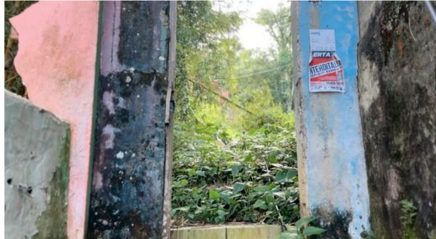
Figura 1: Placa de interdição em casas da Vila Sahy, em São Sebastião. Fonte: TV Vanguarda
