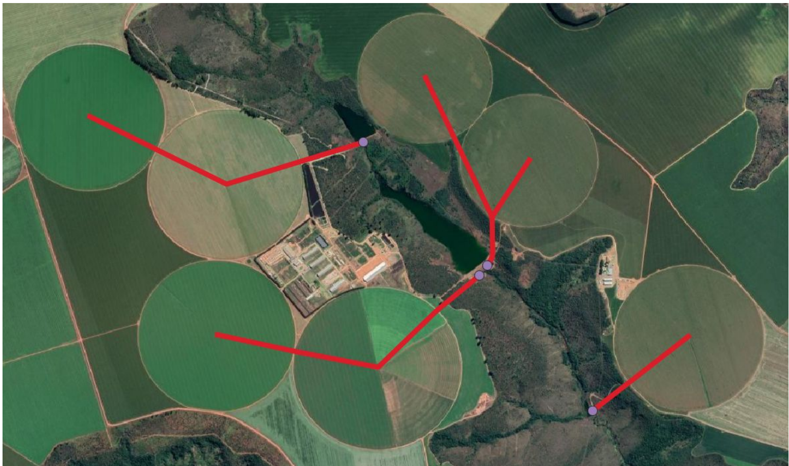
Bombas de captação em barramentos (em roxo) e adutoras (em vermelho) alimentando pivôs centrais no Polo de Irrigação de São Marcos - GO
