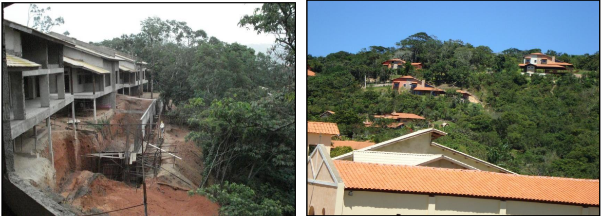
Figura 16: Unidade multifamiliar com significativos cortes das vertentes.
