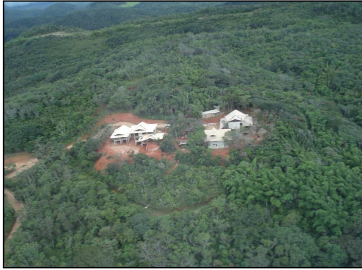
Figura 15: Unidade multifamiliar em construção sobre um relevo de meia laranja no município de Guaramiranga-CE.
