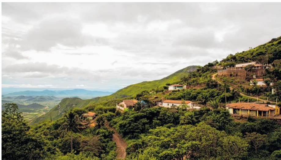
Figura 8 – Loteamento e construções nas encostas íngremes na região da APA da Serra de Baturité.
