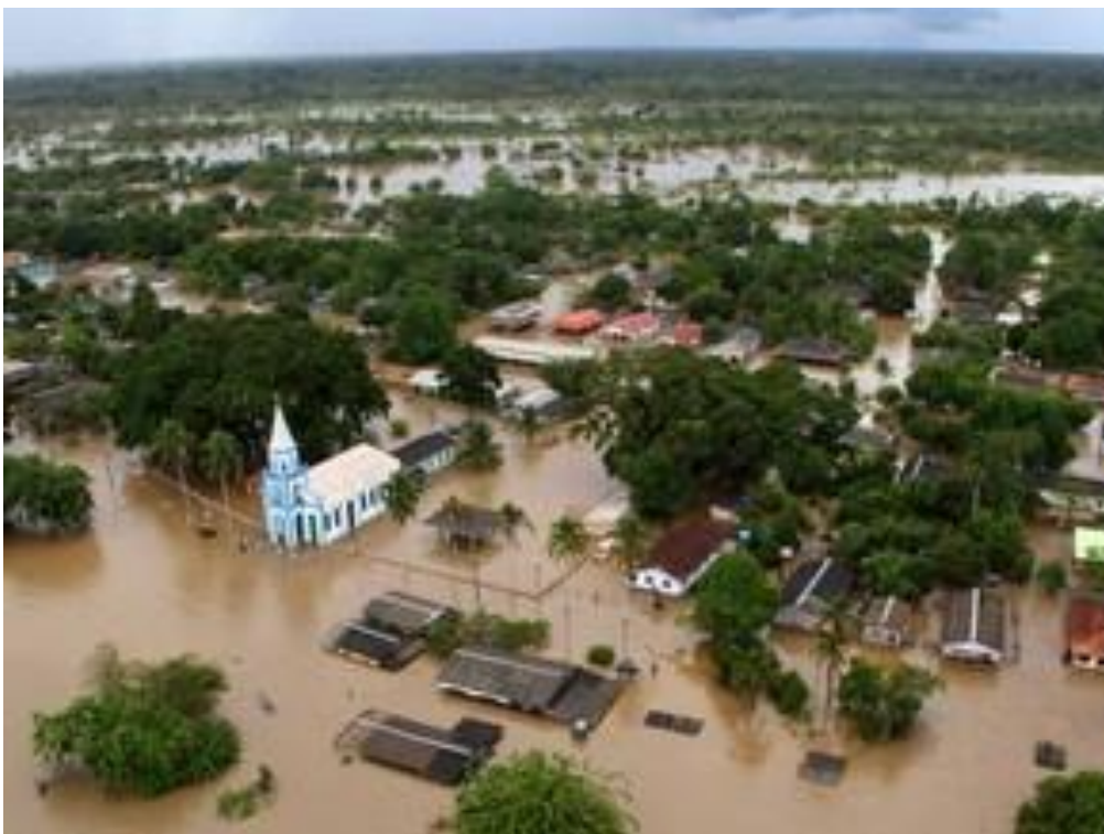
Fig. 2: Inundação Em Porto Velho, 2014. Fonte: G1 (2020).
