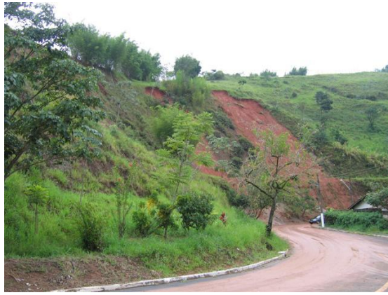
Figura 6: Escorregamento em rodovia. Fonte: Instituto Geológico de SP (2012).
