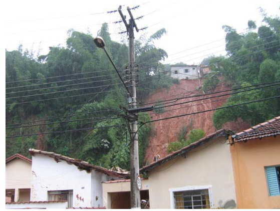
Figura 7: Escorregamento em moradias. Fonte: Instituto Geológico de SP (2012).
