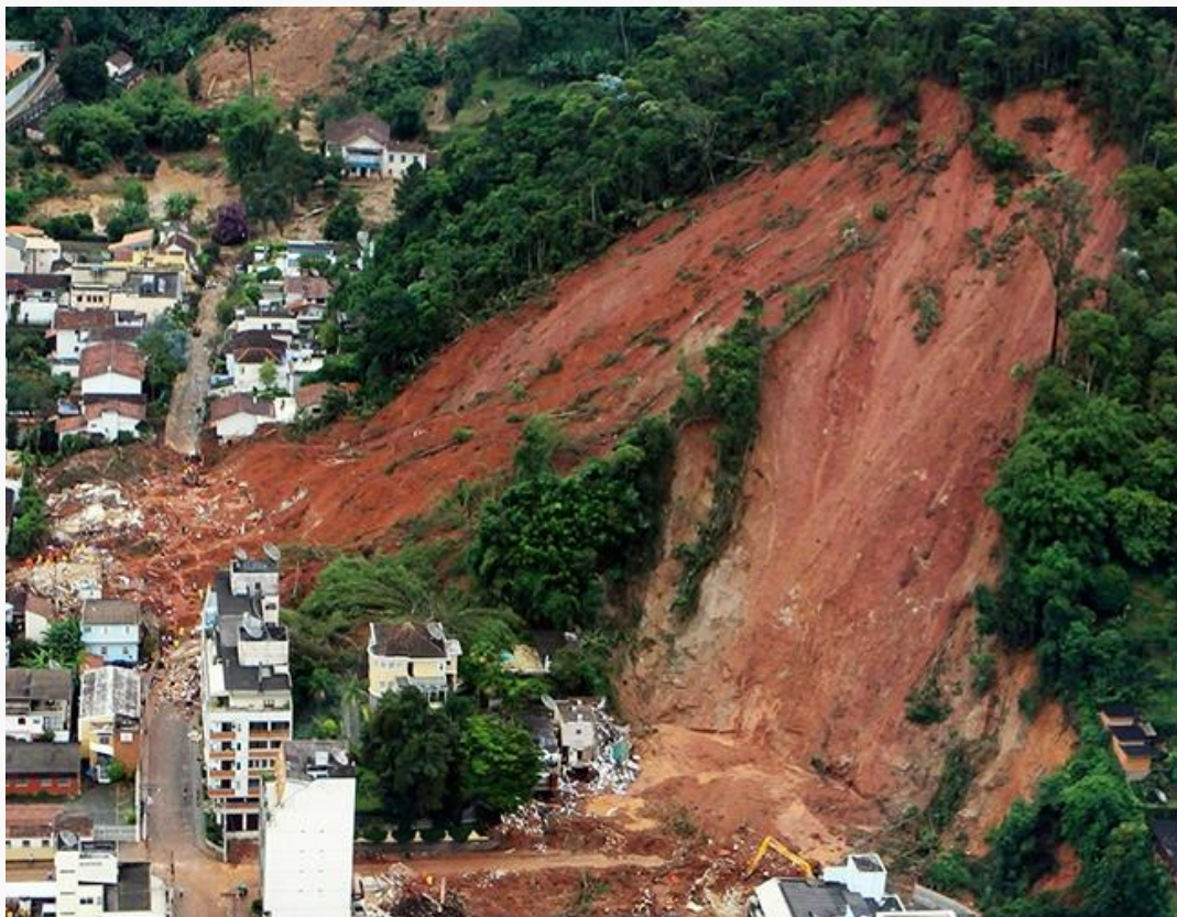
Deslizamento em Nova Friburgo, RJ - 2011 (Pedroni, 2017)
