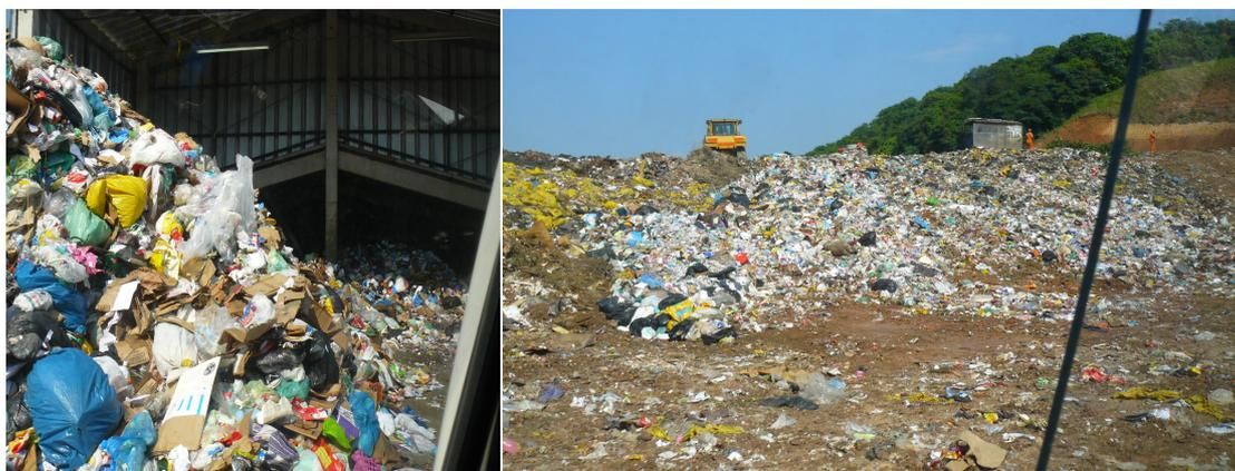
Figura 01 – Estação de Tratamento de Resíduos Sólidos de SJC. Do lado esquerdo os resíduos provenientes da coleta seletiva sendo preparados para posicionamento nas esteiras de triagem; e à direita, o lixo remanescente da triagem que não pode ser reciclado – os resíduos inservíveis - sendo enterrado no aterro sanitário. Foto (arquivo pessoal) 6/dez/2012.
