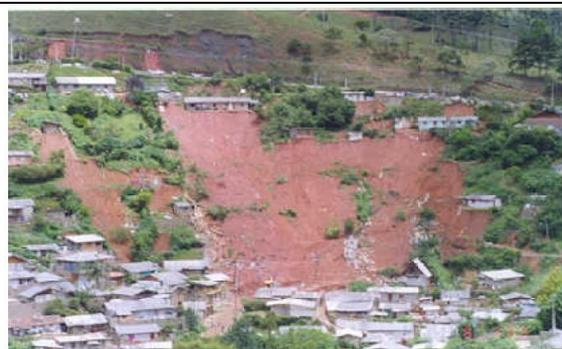
FOTO 02. Escorregamento de grandes proporções, envolvendo cortes e aterros, com a destruição de várias moradias.
