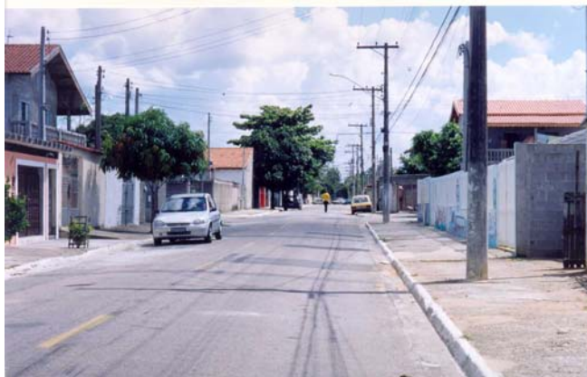
Figura 19 - Um bairro de moradia popular em relevo favorável, que dispõe de uma boa infra-estrutura instalada.
