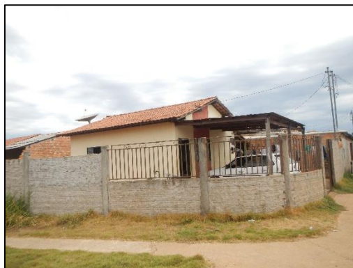
Figura 9: Foto realizada em campo em 2017 de um loteamento na cidade de Sinop em área de expansão do período 2010 - 2012.
