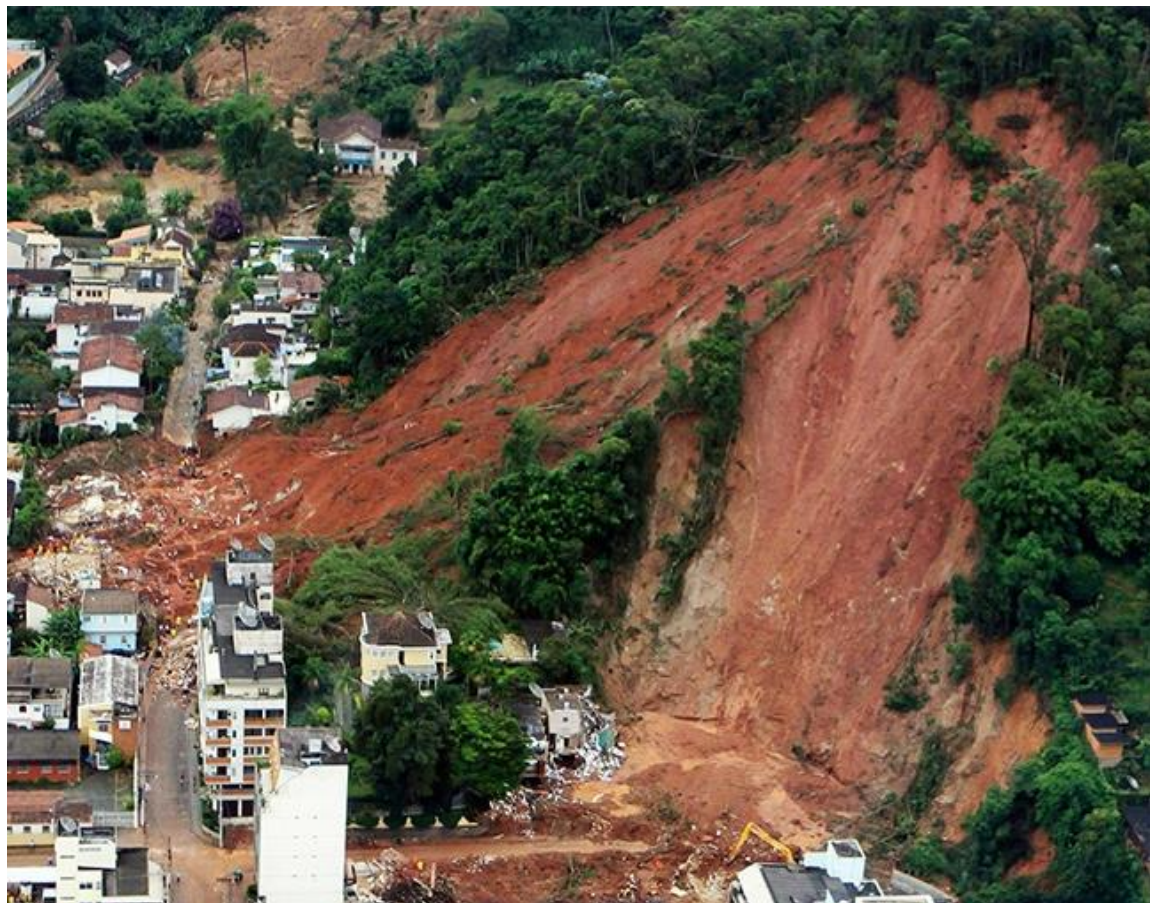
Deslizamento em Nova Friburgo, RJ - 2011 (Pedroni, 2017)
