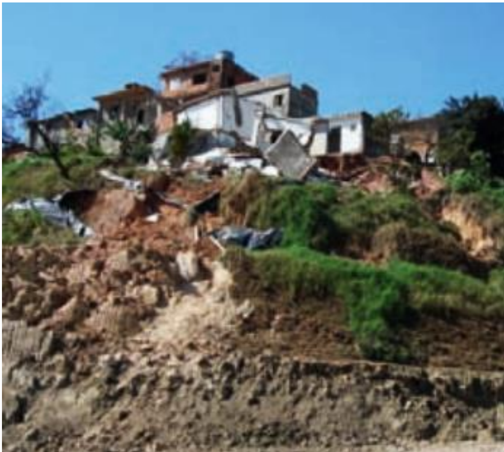
Escorregamento em talude de corte, Jandira, SP (Tominaga et al., 2018)
