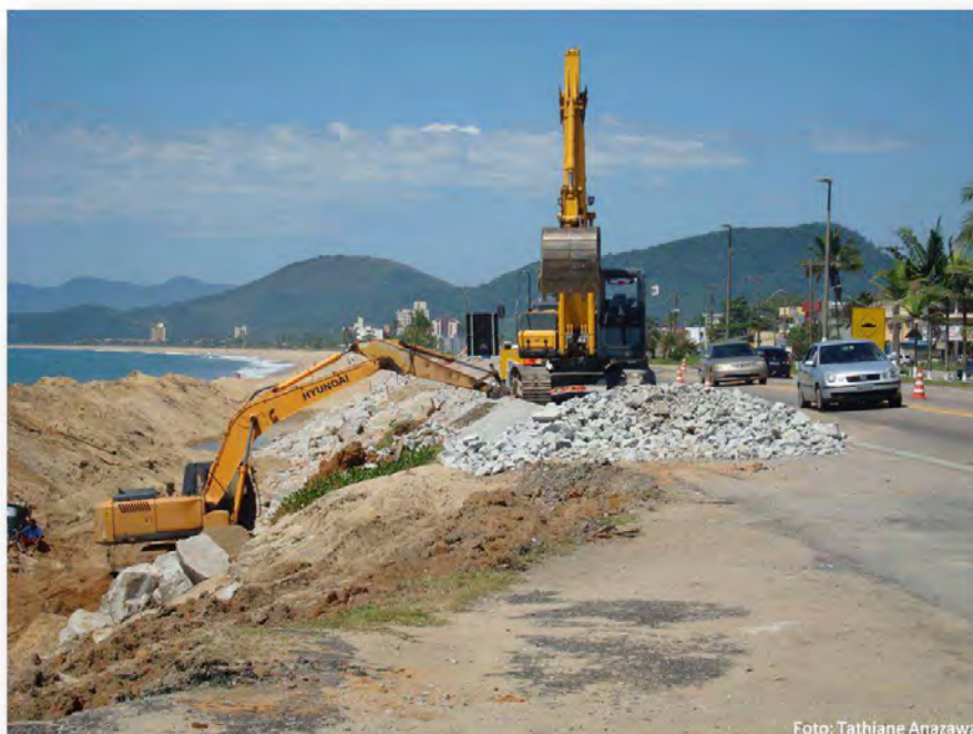
Figura 4.33 - Registro fotográfico das obras na praia de Massaguaçu para corrigir a erosão e minimizar os alagamentos da Rodovia SP-55 adjacente (Janeiro de 2012).
